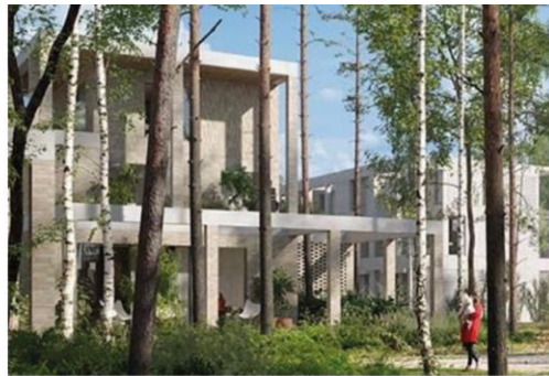
Meeontworpen bijgebouwen, erkers en veranda's
